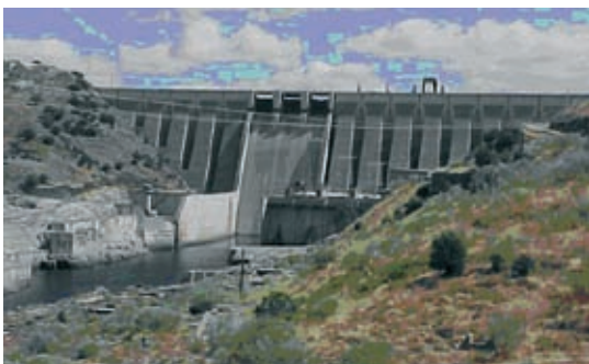
Fig. 10.4 Central hidroeléctrica "José María de Oriol" sobre el río Tajo en la localidad de Alcántara.
