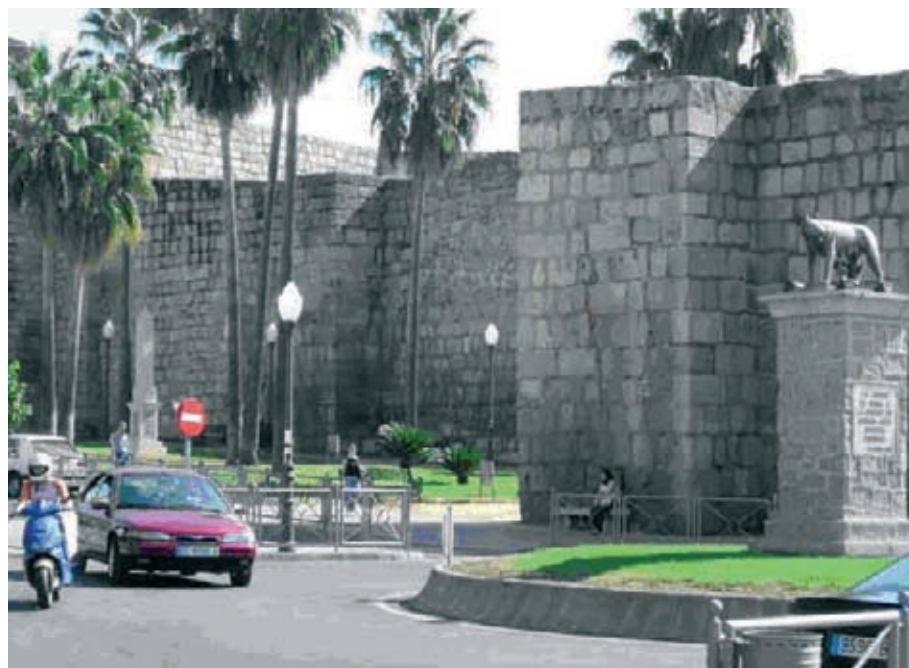
Fig. 10.19 Mérida, murallas y alcazaba. Las murallas de Mérida fueron restauradas por Eurico en el 483.
